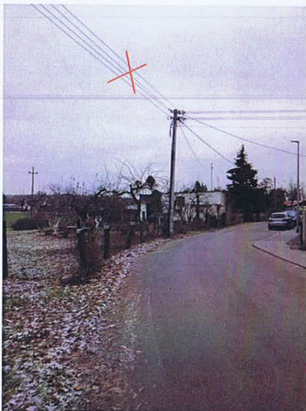
słup 305 / ROK E-10,5/10 obw. 300, T-5988 do wymiany na E-10,5/25 nr 330988-03/5
